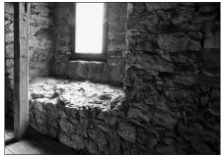
Abb. 9 und 10: Die Fotos lassen die ursprünglichen großen Fensteröffnungen und spätere Einbauten erkennen. (Foto links: Hagemann, rechts: Schäfers)
