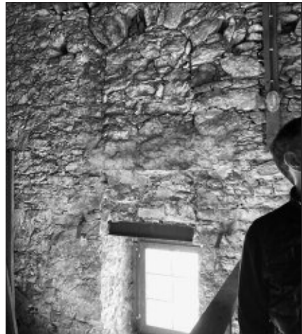
Abb. 18: Das 1900 eingebaute Fenster an der inneren Westseite des Turmes (Foto: Hagemann)
