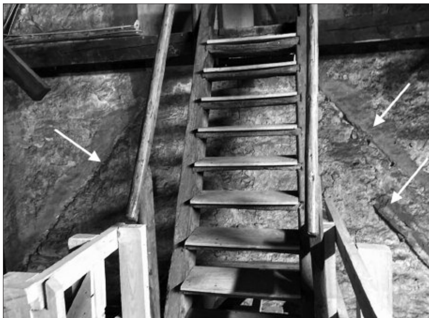
Abb. 14: Mörtelspuren des Dachansatzes der Kirche von 1822 am Turm
