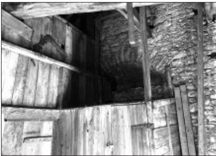
Abb. 9 und 10: Die Fotos lassen die ursprünglichen großen Fensteröffnungen und spätere Einbauten erkennen. (Foto links: Hagemann, rechts: Schäfers)
