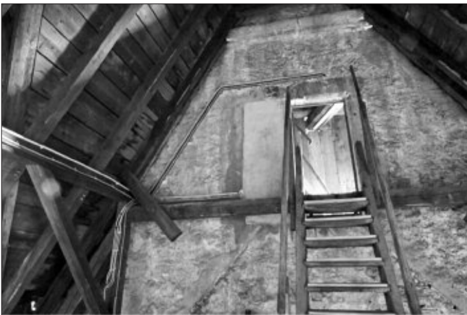
Abb. 12: Das einstige Turmfenster als heutiger Zugang zum damaligen Glockengeschoss (Foto: Schäfers)
