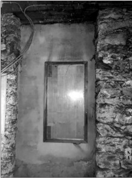
Abb. 7: Vermauerter Zugang zur Orgelempore (Foto: Hagemann)
