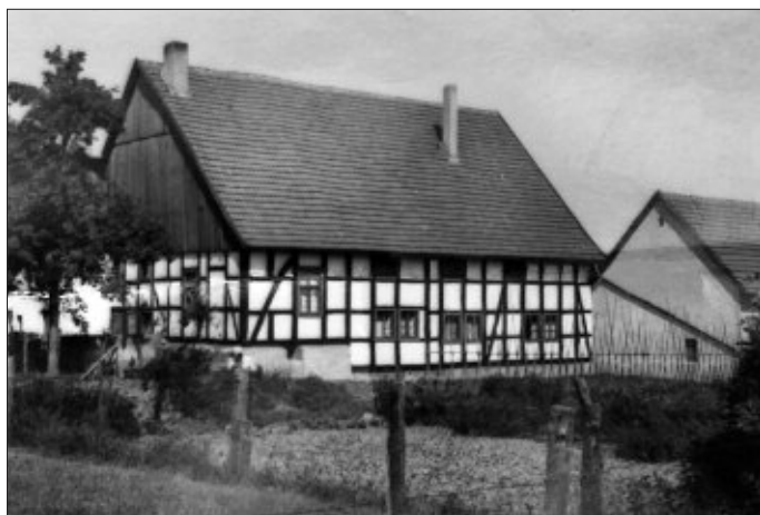
Das Kolonat „Die Osenburg“ an der Josefstraße vor dem Umbau. Das Gebäude wurde nach einer nicht mehr vorhandenen Inschrift 1775 erbaut und ist zu einem nicht bekannten Zeitpunkt von seinem ursprünglichen Standort nach hier versetzt worden. (Foto: Sammlung Heinrich Strate)
