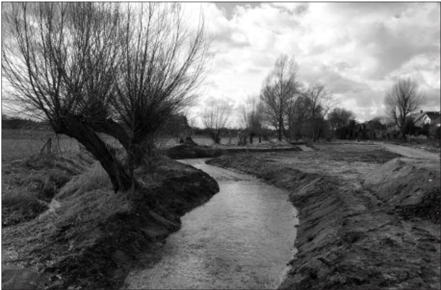
Bild 2: Der Thunebach hat seinen neuen mäandrierenden Lauferhalten. Links im Bild ist das alte Bachbett erkennbar. Die Kopfweiden sind hier standorttypisch. Die Aufnahme ist am 05.03.2017 entstanden.
