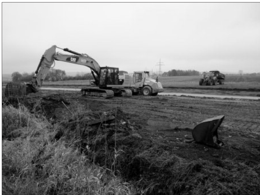
Bild 1: Schwere Baufahrzeuge sind in Bad Lippspringe am Thunebach im Einsatz. Die zukünftige Retentionsfläche (Flutmulde für Hochwasser) wird vorbereitet. Die Aufnahme ist am 02.01.2017 entstanden.
