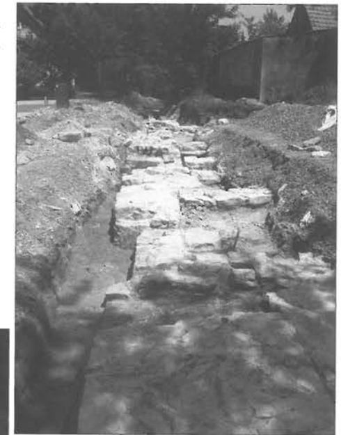
Abbildung 2: Die freigelegten Fundamente parallel zur Burgstraße in Richtung Villa Schlepper gesehen.
