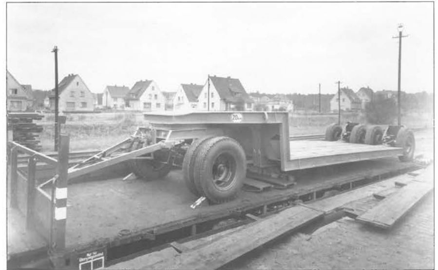
Zum Transport von Dolberg-Baggern gefertigter Nass & Heuser-Tiefladeanhänger 1955 bei der Verladung im Bahnhof Bad Lippspringe. Im Hintergrund der noch nicht vollständig bebaute Bereich Dr.-Pieper-Straße / Mersmannstraße.
