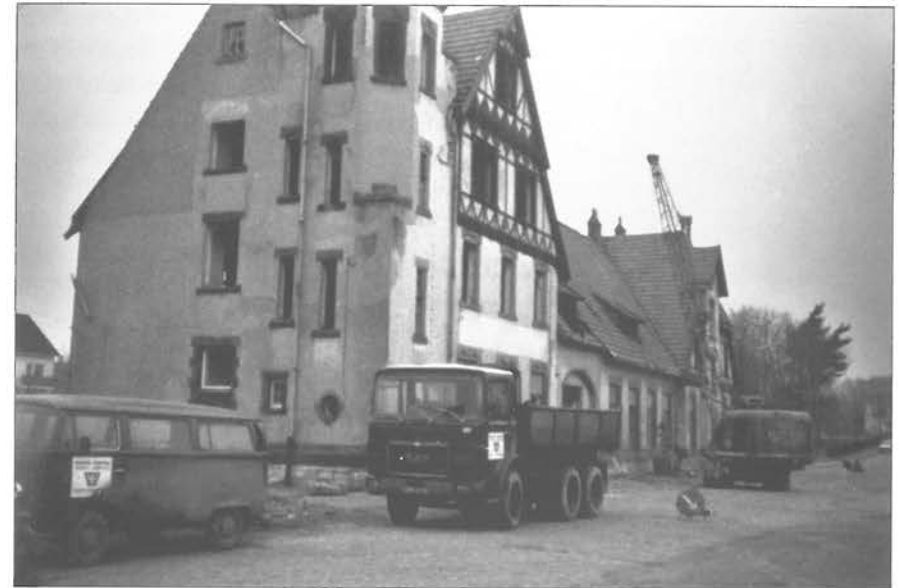
Das einst prächtige Bahnhofsgebäude kurz vor dem Abriss im Januar 1973. Die Baufahrzeuge stehen schon zum Einsatz bereit. Die letzten Bewohner hatten das Gebäude im Dezember 1972 verlassen. Wegen der Gefahr herabfallender Dachziegel war das heruntergekommene Gebäude vorsorglich eingezäunt worden. (Sammlung Heimatverein)
