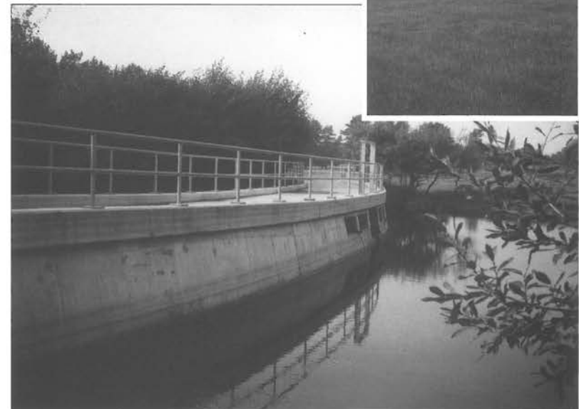
Boelke Stausee nach der Renovierung 2003
