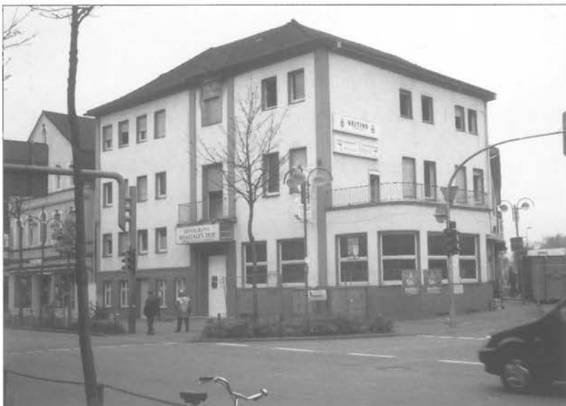
Die Abbrucharbeiten am Westfalenhof haben schon begonnen. Aufnahme am 4.11.2002 (Foto: Walter Göbel)
