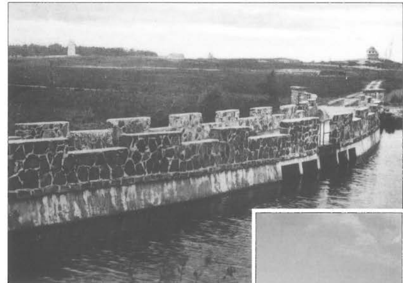
Staumauer des Boelke-Stausees vor dem 2. Weltkrieg
