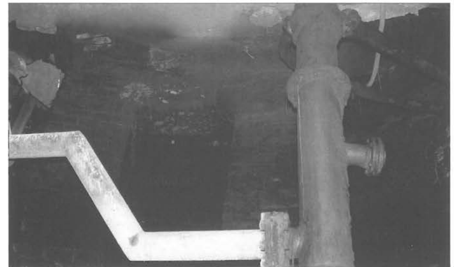
Abb. 8: Rohrleitung vom Brunnenrohr der alten Fassung in die Brunnenkammer der neuen Fassung. Im August 1999 ohne Funktion (Foto: Heuser)
