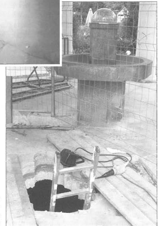
Abb. 4: Karsthohlräum unter der neuen Fassung mit einem heute nicht mehr genutzten Rohr (Foto: BLM)
