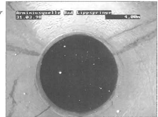
Abb. 3: Unterkante des Brunnenrohres der neuen Fassung (Foto: BLM)
