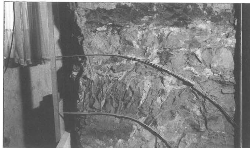
Das vom Putz befreite Wandstück mit dem gekennzeichneten Bogen. In der Bildmitte sind deutlich die senkrecht stehenden Bogensteine zu erkennen. (Foto: Gottesbüren)
