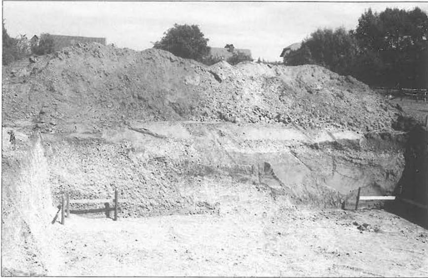
Die Wand der Baugrube nach Osten. Von links nach rechts abfallend zeigt sich die alte Böschung der Steinbeke.
