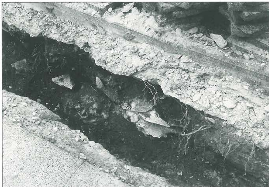
Durchbrochene Fundamente der Stadtmauer am Dammhof.
