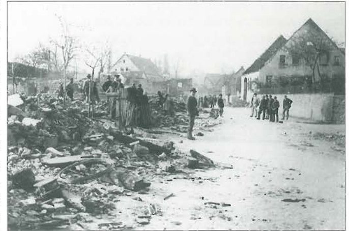
Das beim großen Stadtbrand 1894 zerstörte Pfarrhaus am rechten Bildrand.
