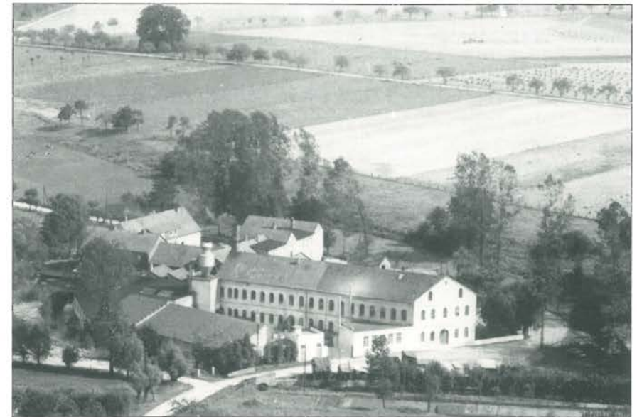
Auf dem Gelände an der Lippe stand über Jahrhunderte die domkapitularische Niedermühle (Butermühle). (Foto: Gottesbüren)
