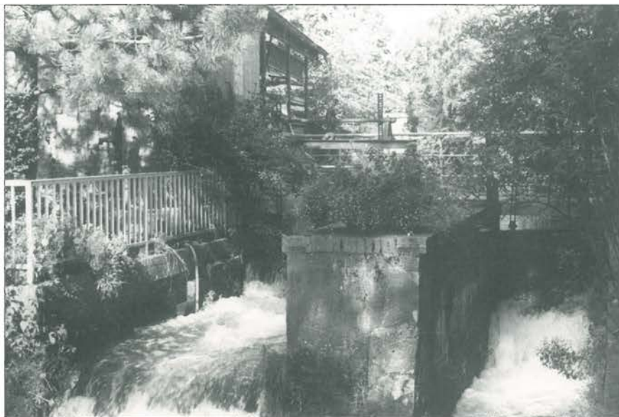
An diesem Wasserfall am Schulzentrum im Bruch soll ein Kleinkraftwerk gebaut werden. (Foto: Gottesbüren)
