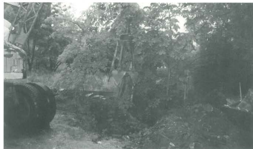
Arbeit bei strömendem Regen. Mit jedem Aushub wird es spannender.
