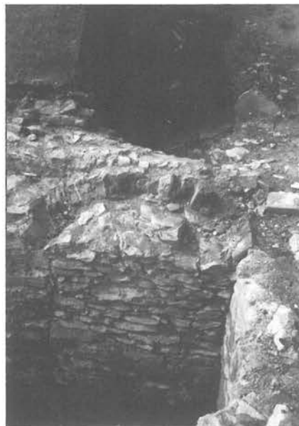
Der um 1680 zugemauerte ursprüngliche Kellereingang
