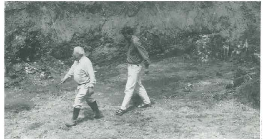
Im Gleichschritt bei der Sicherung von Erkenntnissen: Stadtheimatpfleger August Leimenkühler (vorn) und der Archäologe Dr. Elger bei der Arbeit in der Baugrube (Fotos (3): Knoll)
