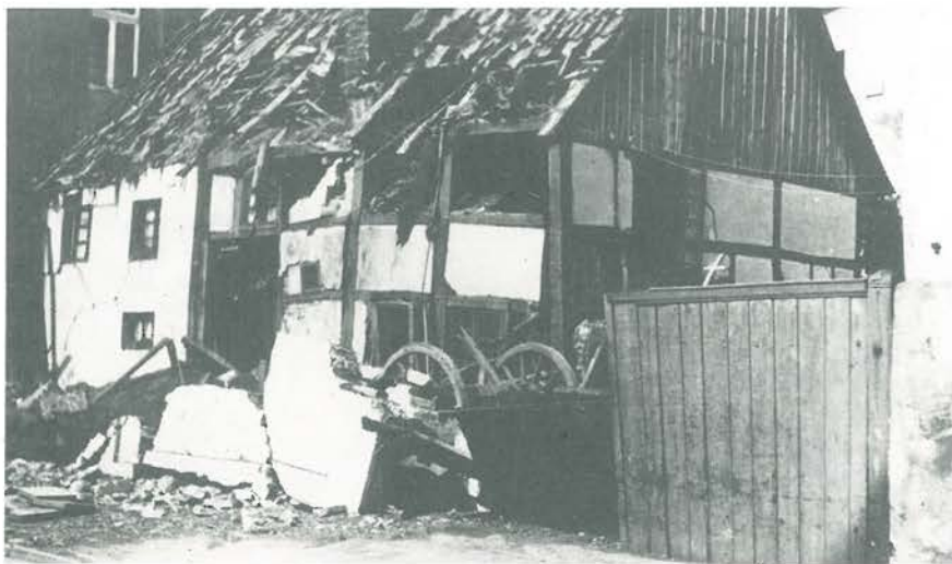
Schwer zerstört: Haus Lange Straße 25
