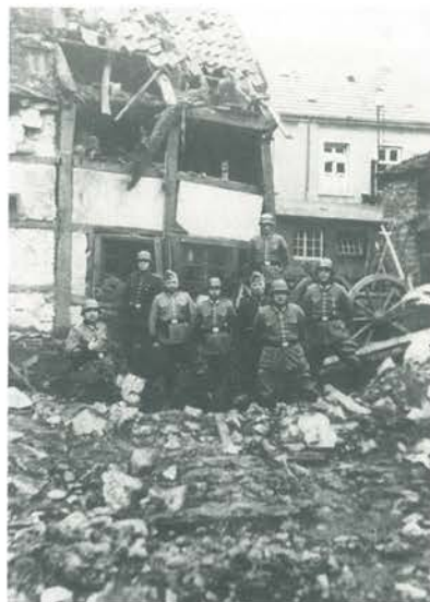
Wehrmachtsangehörige verschaffen sich einen Überblick über den Umfang der Gebäudeschäden.
