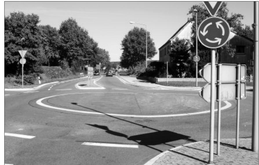
*Für Linienbusse überfahrbare Kreisverkehr in Schlangen. Für Bad Lippspringe wären alternativ auch Kompromisslösungen mit einem kleinen Mittelaufbau denkbar unter Beibehaltung einer (reduzierten) Bepflanzungsfläche.*
