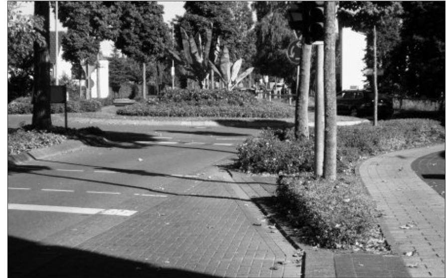
*Haltestelle Westfalen-Therme Richtung Schlangen. Beim Verlassen der Haltestellenbucht muss der Bus eine gesamte Fahrzeugbreite nach links schwenken, um dann unmittelbar danach scharf rechts in den Kreisverkehr einzubiegen. Wenn ausgestiegene Fahrgäste die Bedarfssampel betätigen, wird der Bus mangels Ampelbeeinflussung schon im Verlassen der Haltestelle erneut aufgehalten.*
