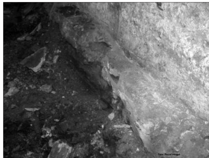
Abb. 1: Die stärkere, ältere Grundmauer des abgerissenen Hauses Marktstraße 24
